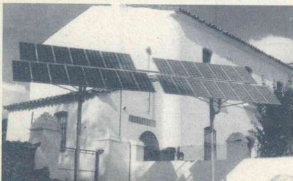
energía solar fotovoltaica. JO-GA-SOL
